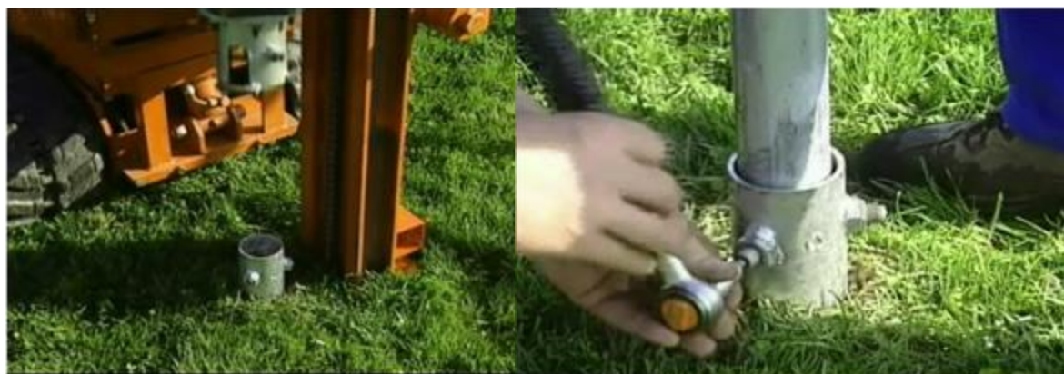
Слика 17. Вкопан клин во земја и поставување на носечката конструкција на него.
