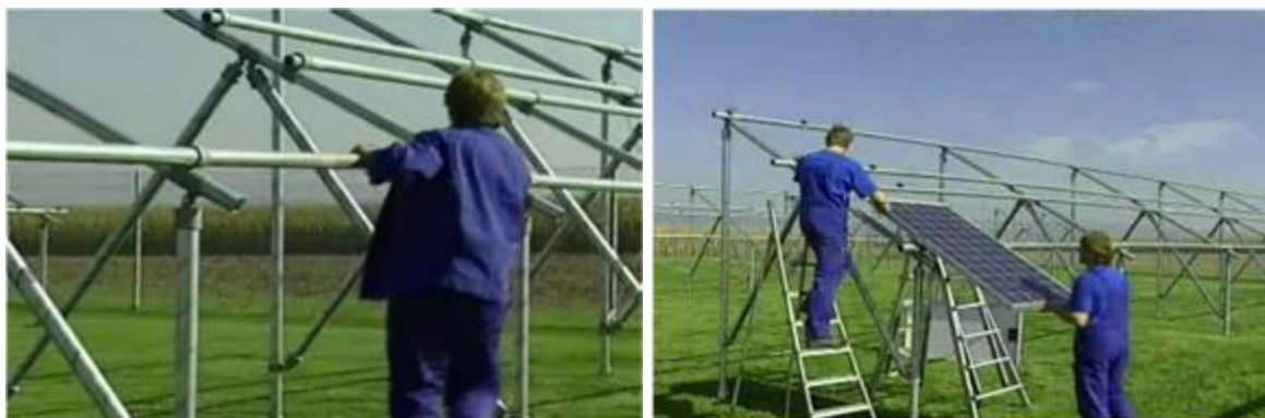
Слика 18. Монтажа на носечка конструкција и PV модули.
