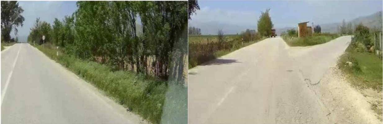
Слика 4 Нередовно одржуваните рабници може да предизвикаат задржување на водата на коловозот - Пресек кон населба Црнобуки на км 3 + 623
