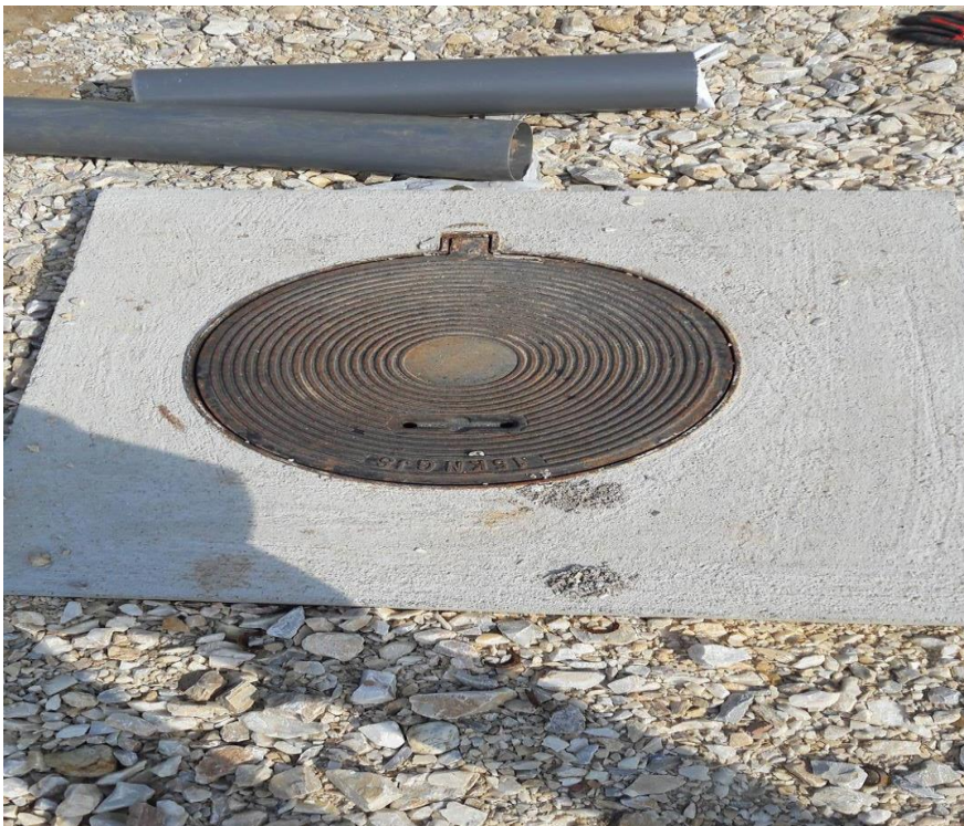
Слика 27 Мерно место за технолошка отпадна вода
