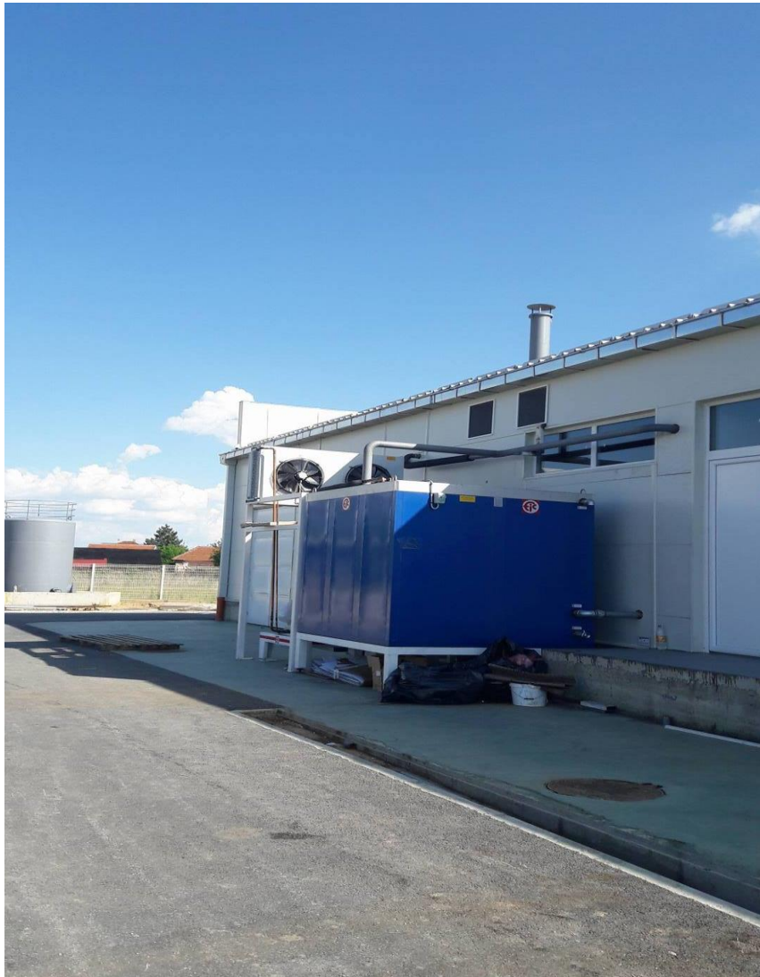
Слика 21 Систем за ледена вода FIC Италија
