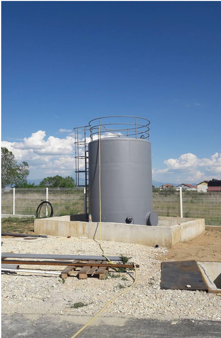
Слика 20 Цистерна за нафта со заштитен базен
