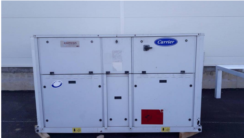
Слика 22 Чилер за ладење на комори Carrier 30 RA 120
