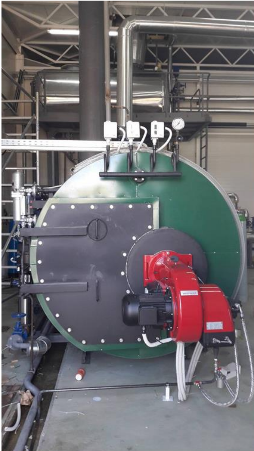
Слика 19 Парен котел ТПК ОрOMETAL Славија и пламеник Weishaupt
